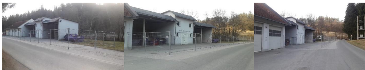
Neuer Begrenzungszaun rund um das ASZ Edelsgrub (Bauhof).
