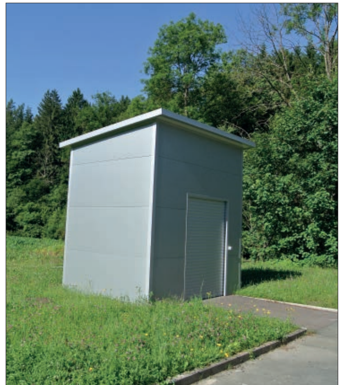
Kläranlagen in Edelsgrub
